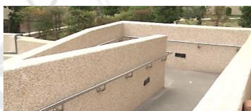
圖 19 戶外南側連接洗手間斜坡
