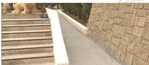
圖 18 禮敬大廳樓梯側邊斜坡
