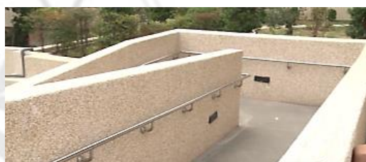
圖 19 戶外南側連接洗手間斜坡
